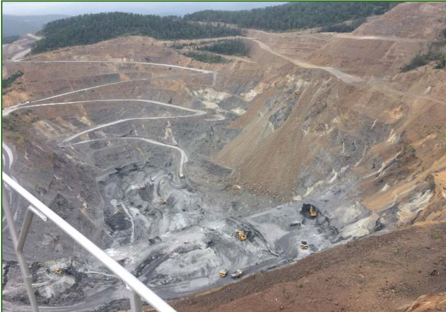
Рис. 1 Общий вид карьера месторождения «Березитовый рудник»
